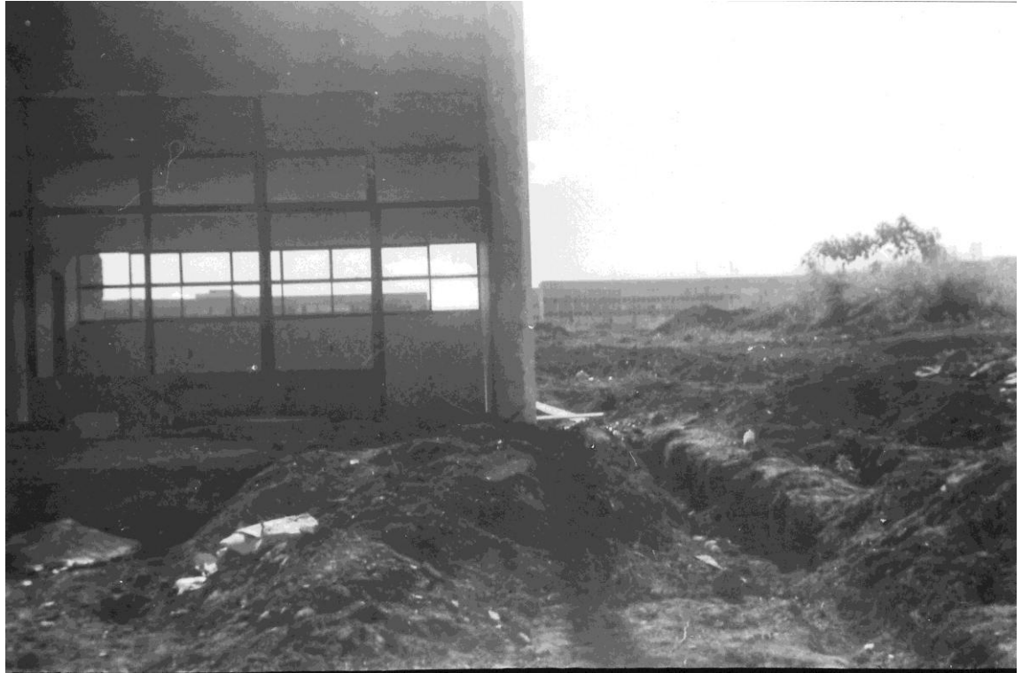
Construção da nova casa em Brasília
